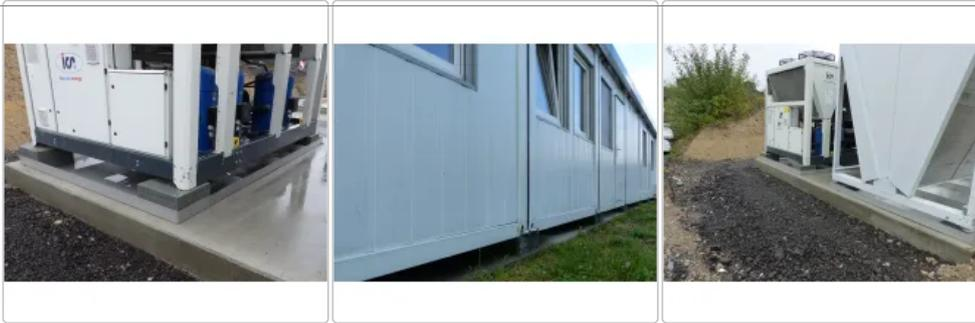
Die Container / Unterlegplatten aus dem Recycling-Kunststoff hanit® können einfach zugeschnitten und abgelängt werden. Das Recyclingmaterial lässt sich leicht be- und verarbeiten und eignet sich daher hervorragend für den Aufbau individueller Konstruktionen oder zum Schutz vor mechanischen Einwirkungen. Aufgrund der Materialeigenschaften können Oberfläche, Farbe und Abmessungen Schwankungen unterliegen.
