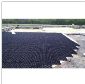
Hanpave aus hanit® ist ein Hochleistungsverbundelement aus Kunststoff. Es ist sehr widerstandsfähig, wartungsarm und eignet sich hervorragend für die Befestigung von Flächen wie Rasen und feuchtes Erdreich. Hanpave-Elemente sind leicht zu verlegen, hochbelastbar und daher die perfekte Lösung, um Parkplätze, vielgenutzte Durchgänge, Rad- und Gehwege trockenzuliegen. Passende weiße Markierungselemente sind als Zubehör erhältlich.
